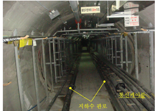
[그림 1] 케이블을 수용하는 통신구의 모습
