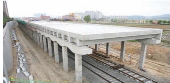
사진 8. 장항선(천안 ~ 온양온천) 복선전철 노반개량공사 (공사기간 2008. 2 ~ 2008. 6)
