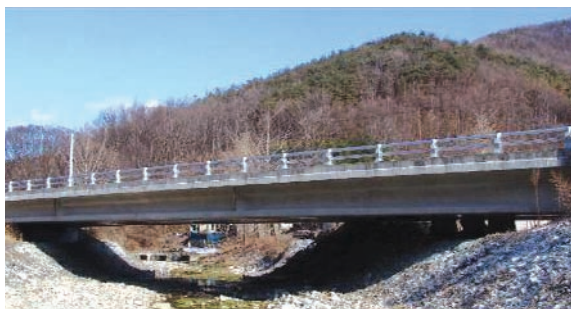
사진 7. 논산 솔골교 수해복구공사(공사기간 2010. 4 ~ 2010. 6)
