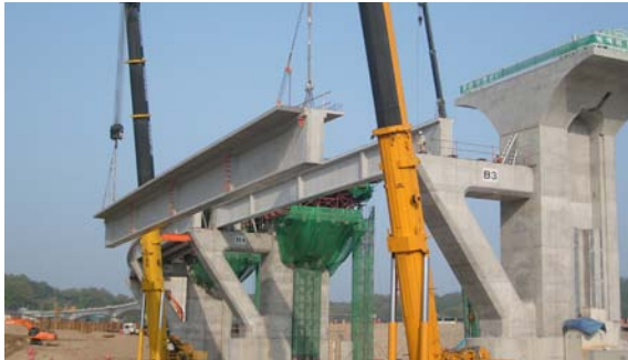
사진 4. 가설 중 체인블럭을 이용한 인양
