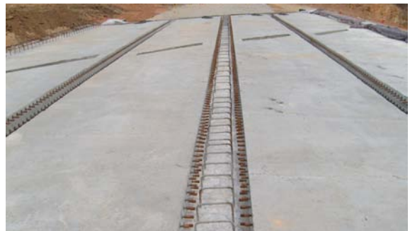
사진 2. APP거더 가설 후 바닥판 상부전경
