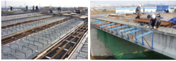
사진 1. 일반적인 바닥판 시공사례
