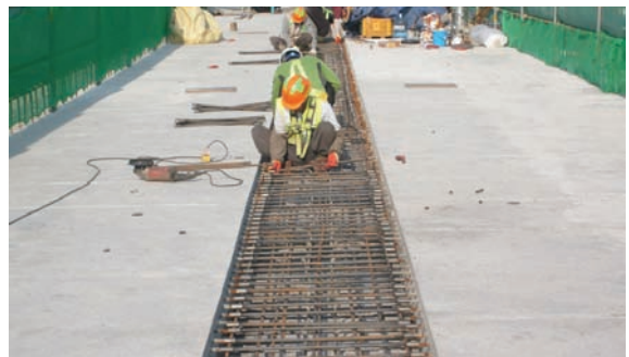
사진 3. 바닥판 연결부 커플러 체결
