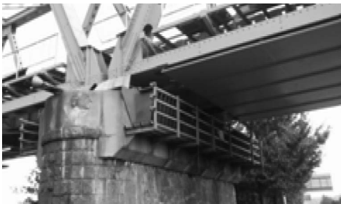
그림 9. 조립식 브라켓 설치
