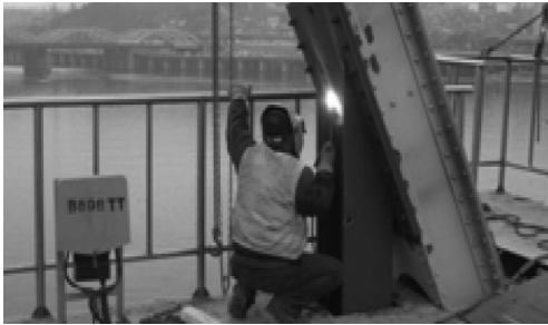
그림 8. 수직보강재 설치
