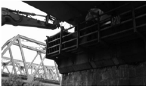
그림 12. 조립식 브라켓 철거
