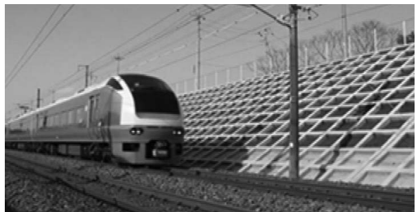
그림 11. 강우 대비 콘크리트격자 프레임
