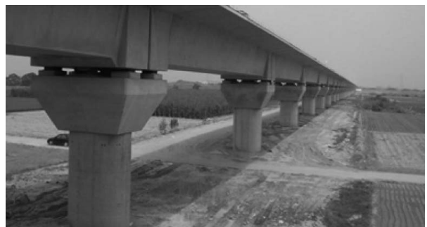
그림 8. 대만 고속철도 지진방지방용 Viaduct
