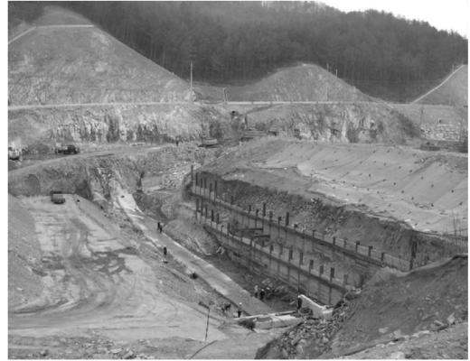
그림 12. 흙막이를 이용한 제당 터파기 및 기초처리 전경
