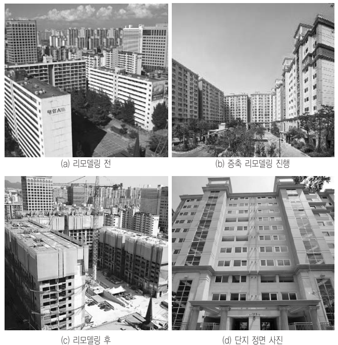
그림 5. 증축 리모델링 시공 사례
