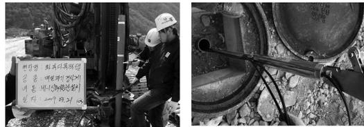
그림 10. 경사계 케이싱 및 자동측정센서 설치
