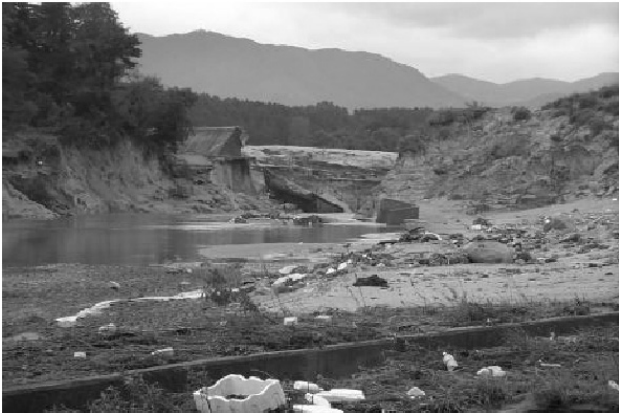
그림 7. 장현저수지 붕괴 상태
