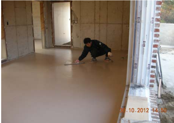
[그림 1] 친환경 석고계 몰탈을 이용한 바닥시공
