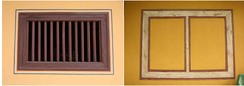
안동 봉정사 극락전 정면 예산 수덕사 대웅전 배면 <그림 10> 고려시대 건물 중 창열굴 I형의 사례
