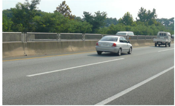
그림 5. 중부선 아스팔트 구간 토공부 (상태양호 IRI : 1.15)
