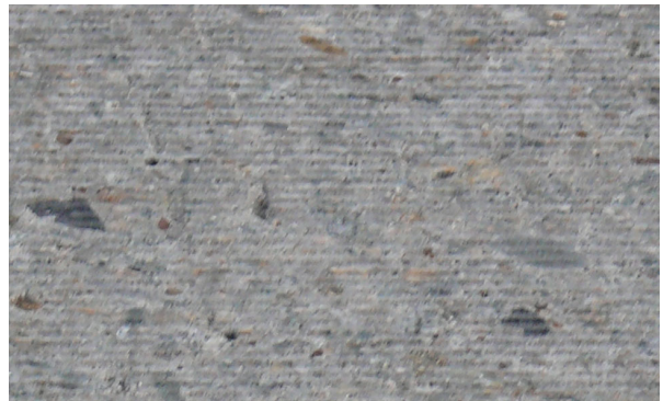
그림 6. 중부선 JPC 다이아몬드 그라인딩 구간 토공부 (상태보통 IRI : 1.43)
