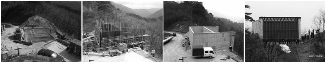
그림 11. 실제 규모 토석류 실험 발생장치의 제작 과정 및 완성된 발생장치의 전경
