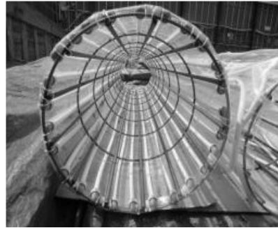
그림 6. 부속연결형 시공 형상
