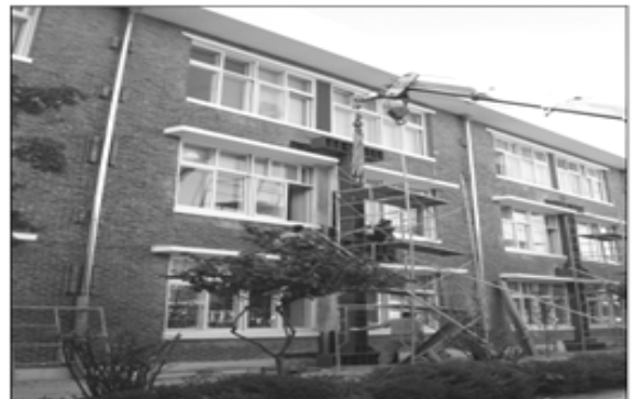
그림 15. 제진보강 시공과정(강재댐퍼 설치)
