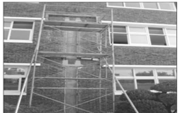
그림 14. 제진보강 시공과정(외부 주열부 파취)
