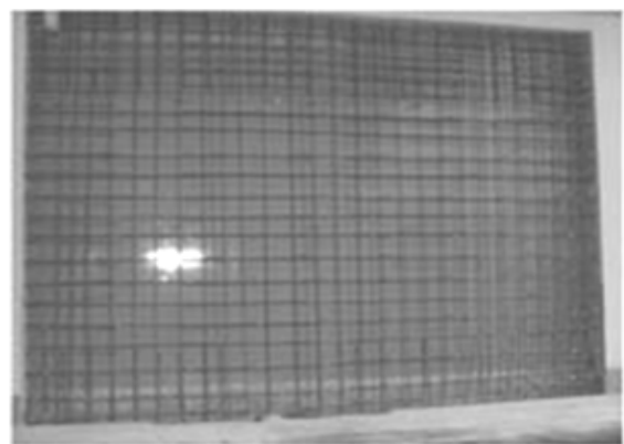
그림 1. 철근콘크리트 내력벽 보강 형상
