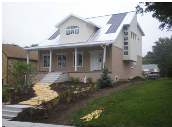
〈Fig. 1〉 Zero Net Energy Test House (ZNETH)
