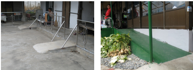
[그림 1] 농어촌 장애인 주택개조 지원사업 오설치 사례
