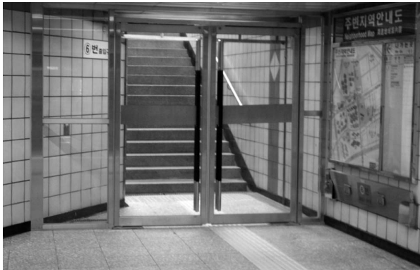
그림 16. 출입구 앞 방풍문 설치
