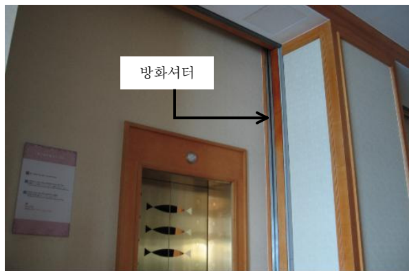
그림 4. 방화셔터를 이용한 ELEV 승강로 방화구획
