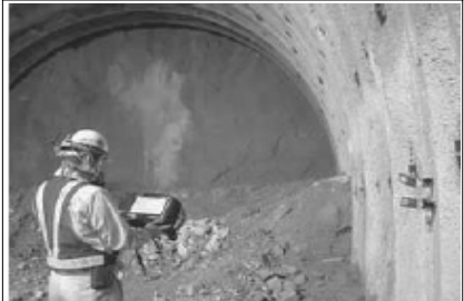
사진 5. 강제 지보공 설치 예
