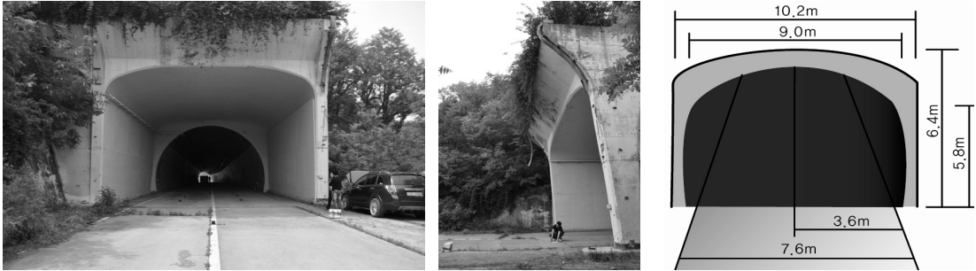
그림 3. 반사거울시스템이 설치될 터널의 형상
