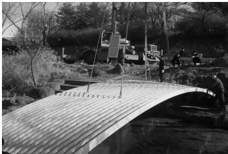
(a) 현장타설을 위한 FRP 부재 설치
