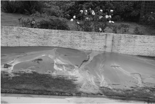
그림 10. 크라이스처치항 도로파괴 및 액상화전경
