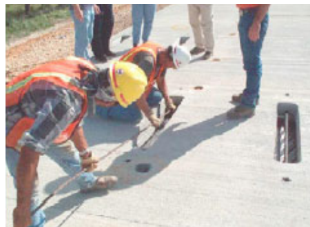
그림 2. PPCP 시스템 설치(Georgetown, Texas)
