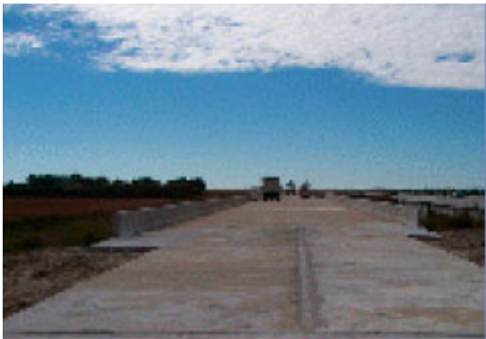
그림 6. PPCP 교량 접속 설치 (Highway 60 near Sheldon, Iowa)
