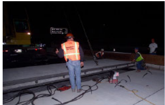
그림 4. PPCP 설치(I-10, El Monte, California)
