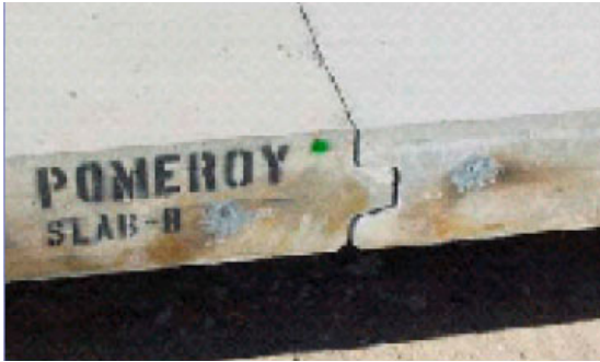
그림 3. Tongue-and-groove keyway
