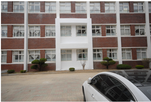
Photo 3 완공 후 상세
