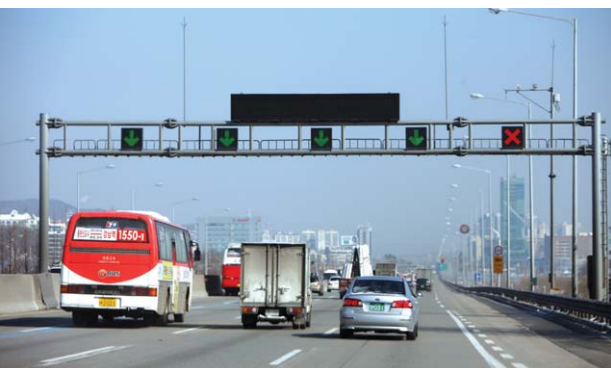
고속도로 갓길차로 설치
