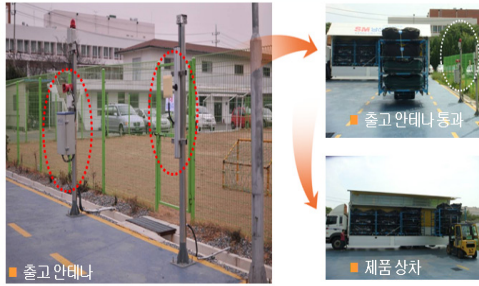
그림 8. 출하 시 이용되는 RFID 시스템 Fig. 8. RFID system for storing
