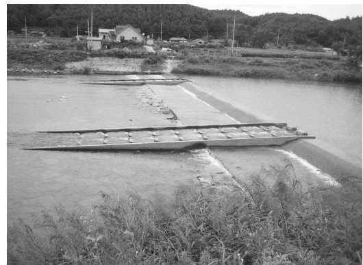
그림 3. 당무개보 좌우측에 각각 설치된 어도
