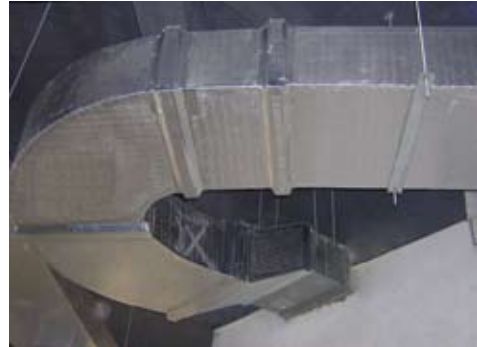
[그림 1] HVAC 시스템의 덕트 환기시스템과 덕트 구조
