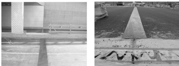
그림 4. 탄성봉합재 설치 후 전경사진
