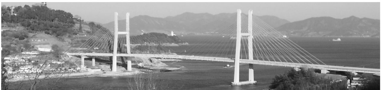
그림 13. 제2돌산대교 시공완료 후 전경(2011.12, 부대공 제외)
