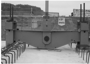
그림 9. 주두부에 설치된 Lifting Beam
