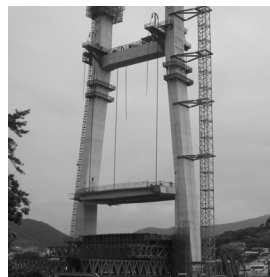
그림 11. Heavy Lifting
