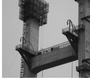
그림 8. Lifting Frame
