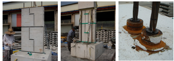
(d) Assembling (e) Grouting (f) Post-tensioning
