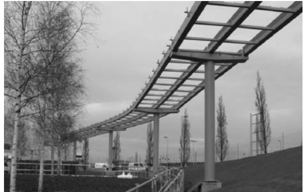
그림 3. 영국 히드로공항 고가구조물 시공 모습
