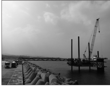
(b) 수중콘크리트 타설
