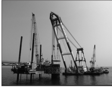
(a) 임시케이싱 설치
