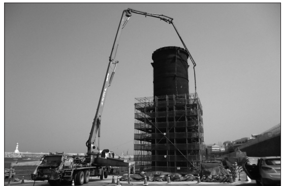
(b) 콘크리트 타설
