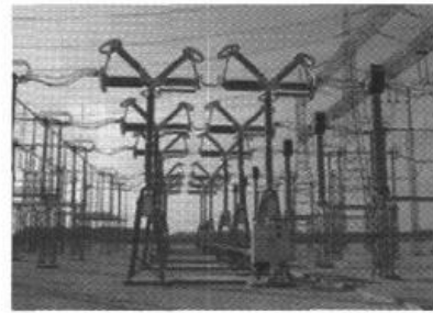
그림 5. 혼합가스가 적용된 캐나다 500 kV 변전소 사례.
