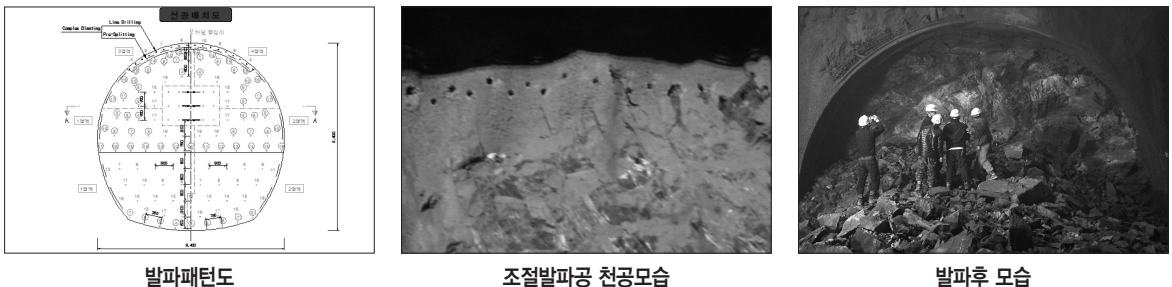
그림 4. 조합형조절발파 공법 발파패턴도와 현장 사진
