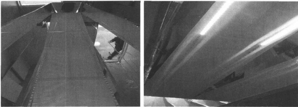
그림 8. 광파이프내 LED 조명 설치
