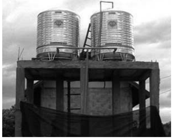
사진 2. 물탱크 탭 위에 탱크설치
