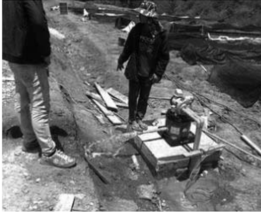
사진 1. 모터 설치 후 시험 가동
