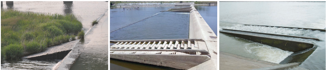
그림 2. 놀이터의 미끄럼틀과 사람이 다니는 계단처럼 생긴 어도. 아주 가끔 어도로 적당량 물이 흐르는 때가 있지만 알고 빨라 뱀장어 등을 제외하면 이동이 어려움. 탐진강.
