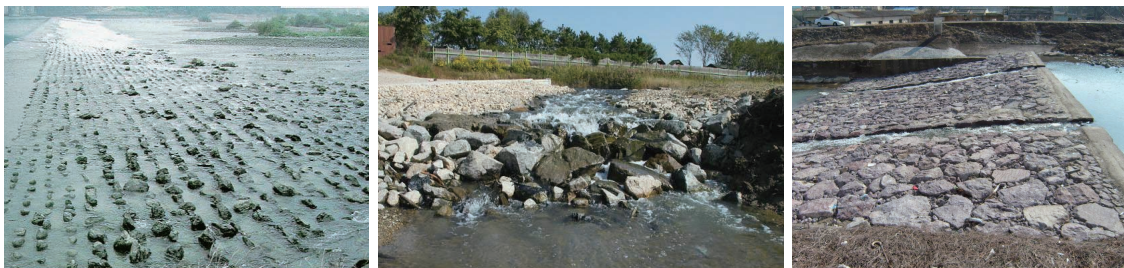
그림 4. 격벽 간격이 넓게 조성된 일본의 어도(좌)와 국내의 돌로 조성된 어도(중, 우). 어도 입구가 세굴되어 진입이 어렵고 내부에서는 도약을 해야 함.
