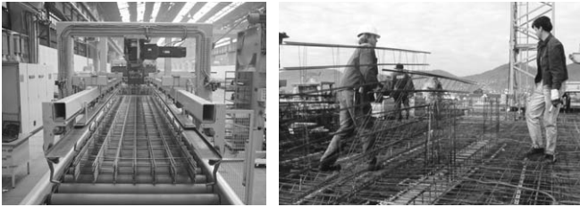
그림 6. 멀티바(multibar) 제작·현장시공
