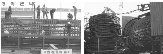
그림 7. 대구경 파일 철근 가공
