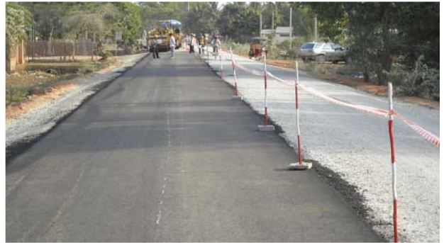
〈차량통제용 안전포스트 설치〉
