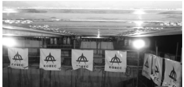
그림 15. 조립식 브라켓 설치
