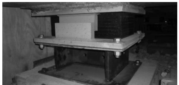
그림 17. 인상후 보강재 설치
