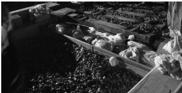
그림 12. 신축이음부 자갈막이 설치
