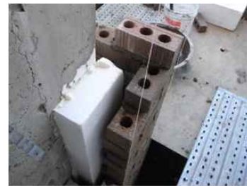
<그림 5> 파주 동패리 패시브 주택 단열재 시공사진
