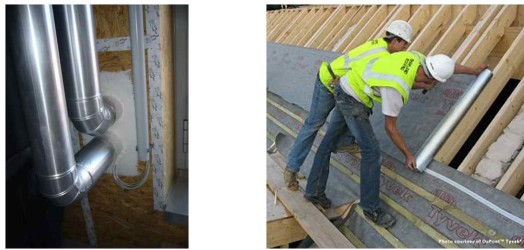
<그림 7> 파주 동패리 패시브주택 기밀성을 높이는 시공사진
