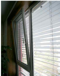
<그림 8> 동탄 패시브 주택 시스템창호 시공사진
