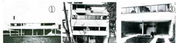
<그림 12> Le Corbusier ① 빌라 사보아(Villa Savoye), 1929 ②③ 메종 쿡(Maison Cook), 1926
