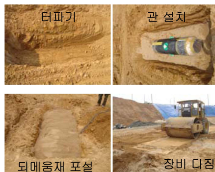
그림 1. 현장 시험시공 단면도 및 사진
