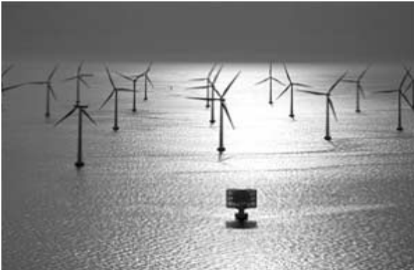
[그림 3] 해상풍력발전단지(해상변전소, 풍력발전기)전경
