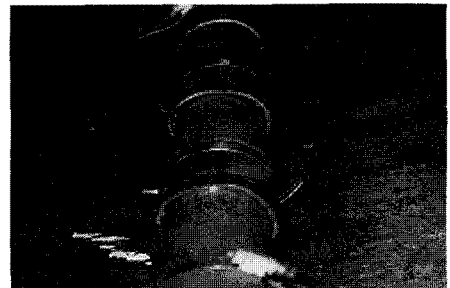
도금된 액비살포기 내부 전경
