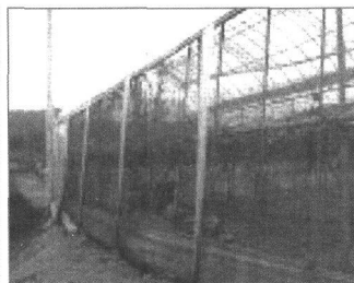
▲ 외부 유입 방지위한 방충망 설치
