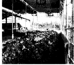
〈퇴비사 지붕 송풍기 설치〉
