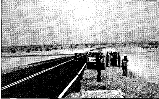
사진 2. 과업 시점부 동골라의 기존도로 현황
